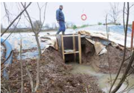
Harte Arbeit – Konstruktion der Ablaufregelung des Spülfeldes und der Einsatz von Schwimmbaggern
