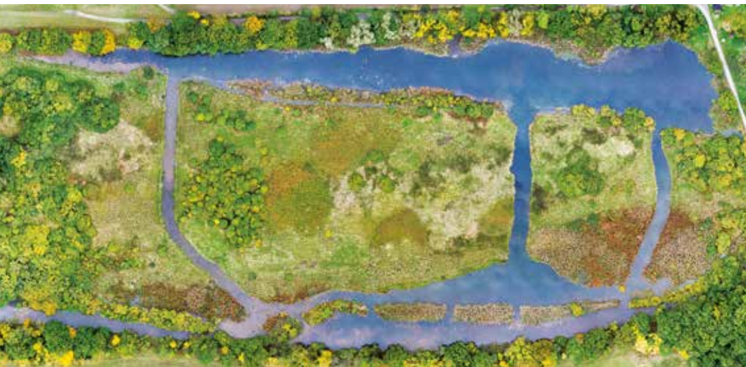
Das Gebiet der letzten Projektphase 2016 nach der Renaturierung
