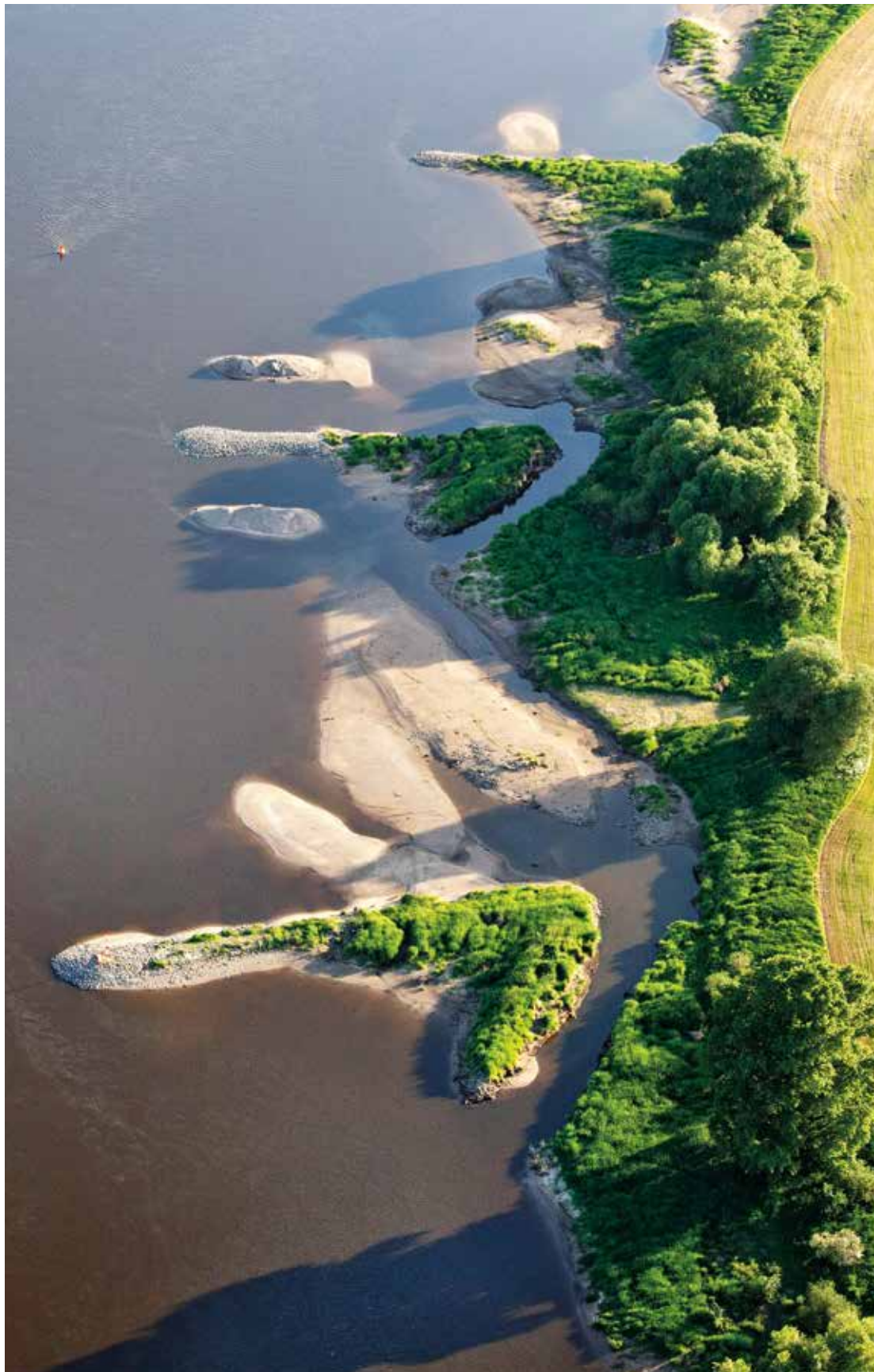
Elbe bei Lutherstadt Wittenberg: Gelungene ökologische Verbesserung von Buhnen
