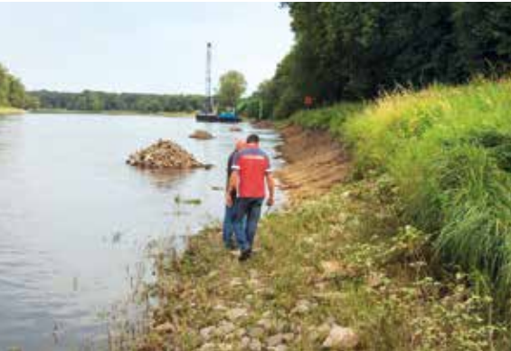
Rückgebautes Deckwerk bei Wahrenberg
