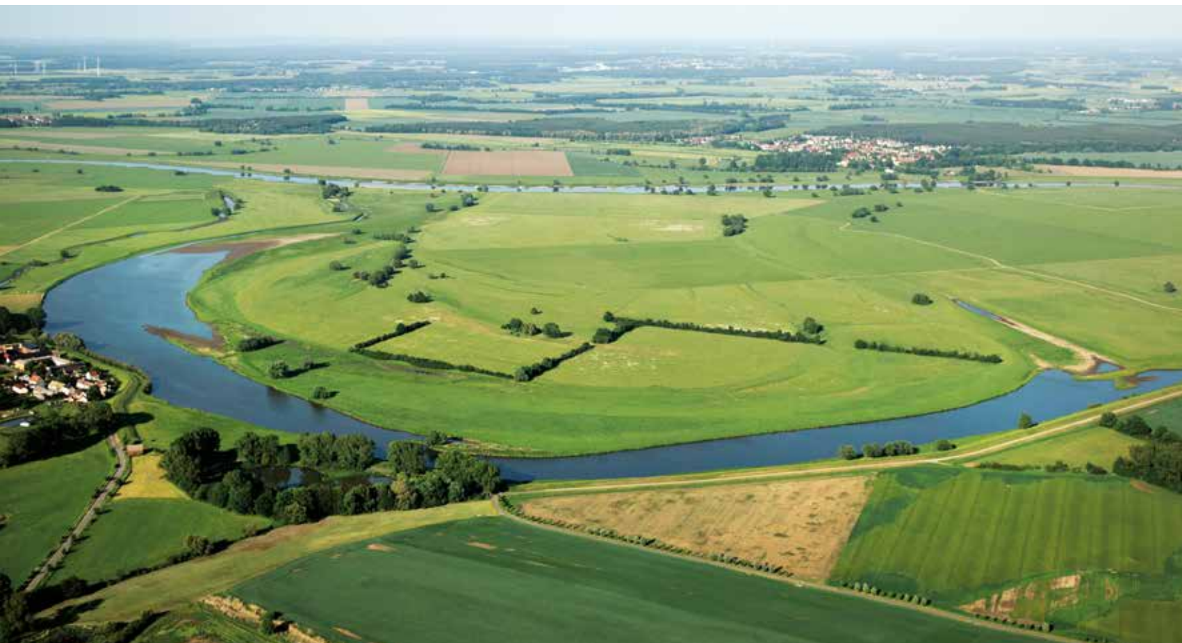
Die alte Elbe Bösewig im Landkreis Wittenberg soll wieder an die Elbe angebunden werden.
